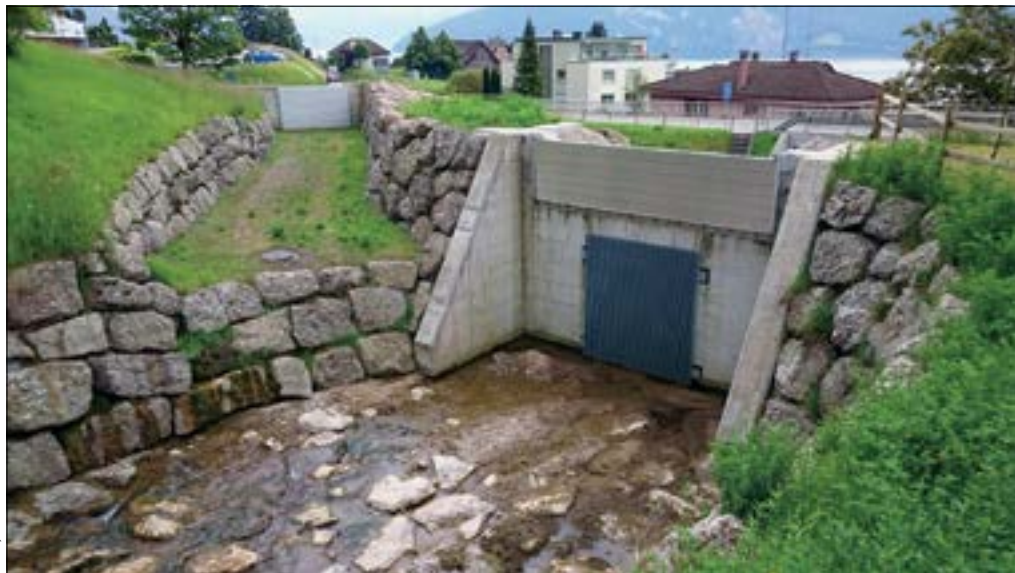
Slika 1: Vtok z rešetko v obzidano kineto in levi bočni preliv za visoke vode kot gradbeni protipoplavni ukrep na hudourniku v kraju Weggis v kantonu Luzern (Švica).
